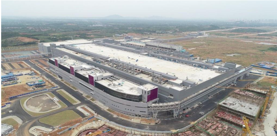
사진 2. 창장메모리기지 1기 건설 전망
