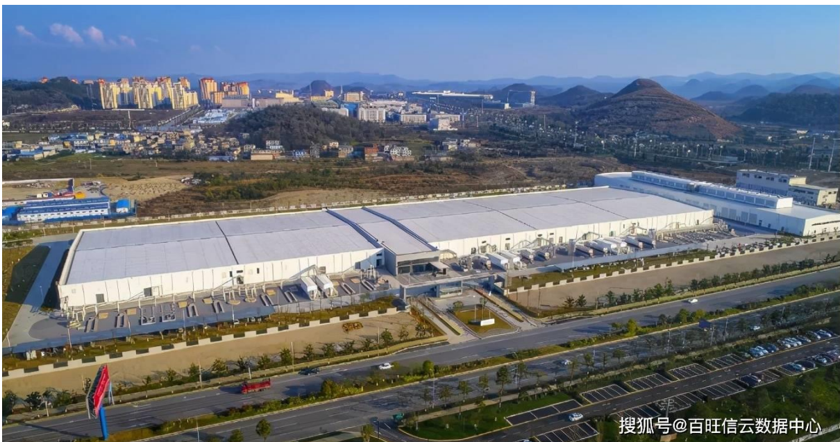
사진 2) 출처: 구이안신구(贵安新区) 공식 사이트. 애플 iCloud 구이안데이터센터(贵安数据中心)
