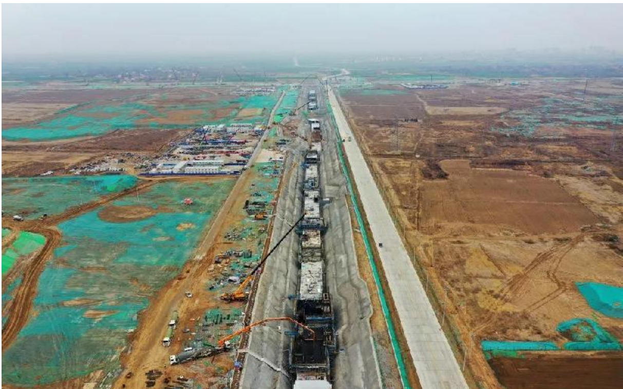
사진 4) 출처: 신화사(新华社) 송안 지하 종합 파이프 통로 시공 현장
