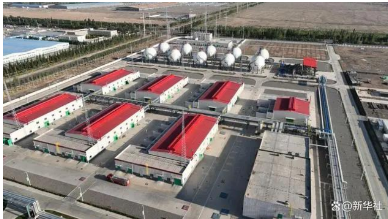
사진 2) 시노펙 신장 쿠차 녹색수소 시범 프로젝트 수소 생산 공장 사진(신화왕)
