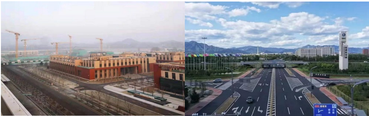
사진 2) 출처: 화이러우과학시티 사이트. 베이징화이러우종합국가과학센터 좌-핵심 건물 시공, 우-입구
